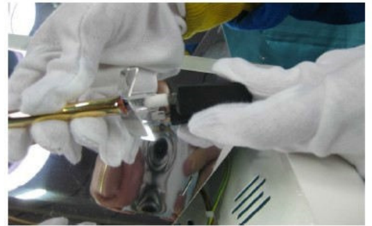
6. CONNECTER A NOUVEAU LES FASTONS SUR LA NOUVELLE LAMPE ET LA RECOUVRIR AVEC LES JOINTS SILICONIQUES.
